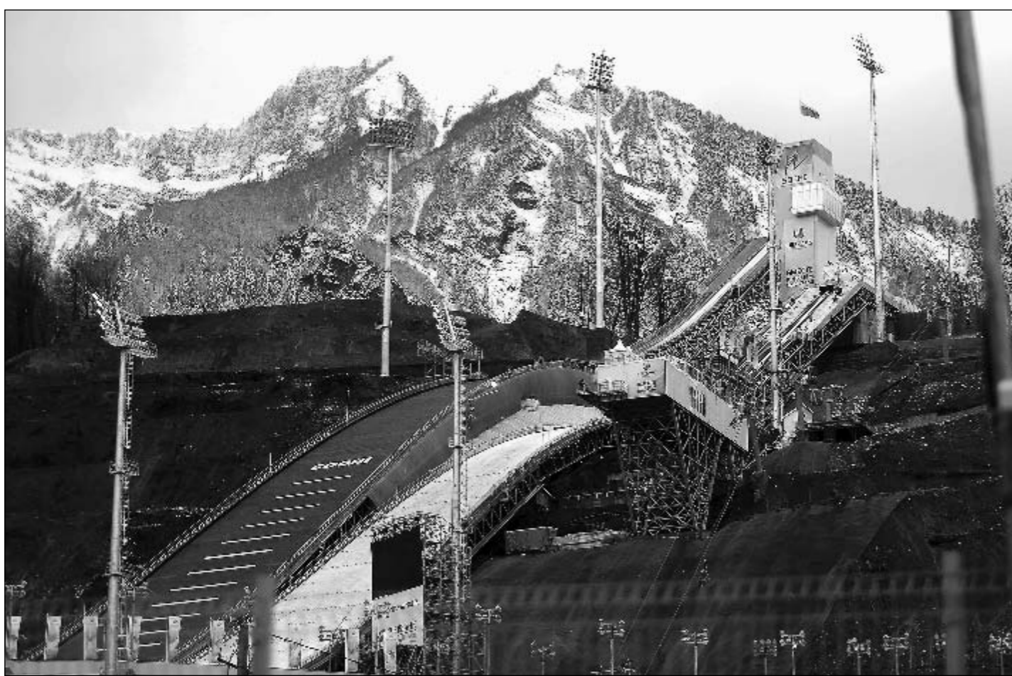
Профили обоих трамплинов практически идентичны. Все размеры указаны по схеме: К-125/К-95.
