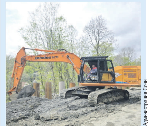
Если позволит погода, то подрядчик ускорит темпы ремонта.
