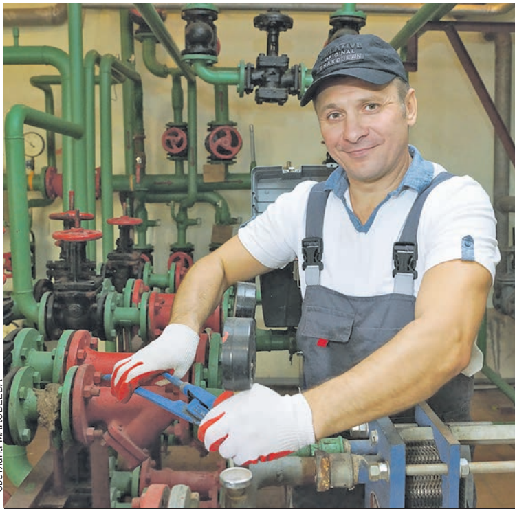
Коммунальщики проходят даже тренировки по отработке аварийных ситуаций.
