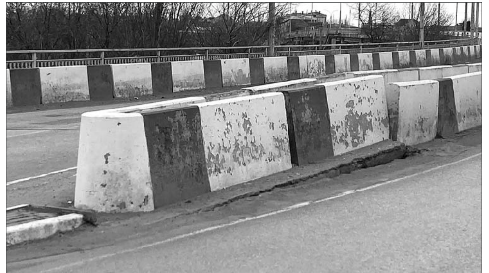
На одной из полос движения просел асфальт.
