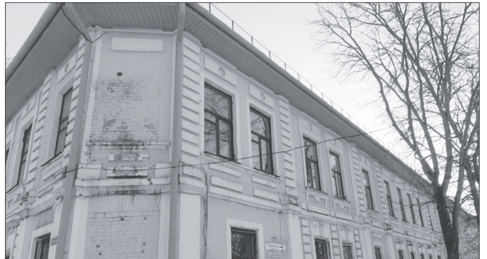
Здание поликлиники является объектом культурного наследия регионального значения.
